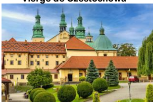
Sanctuaire de Kalwaria
